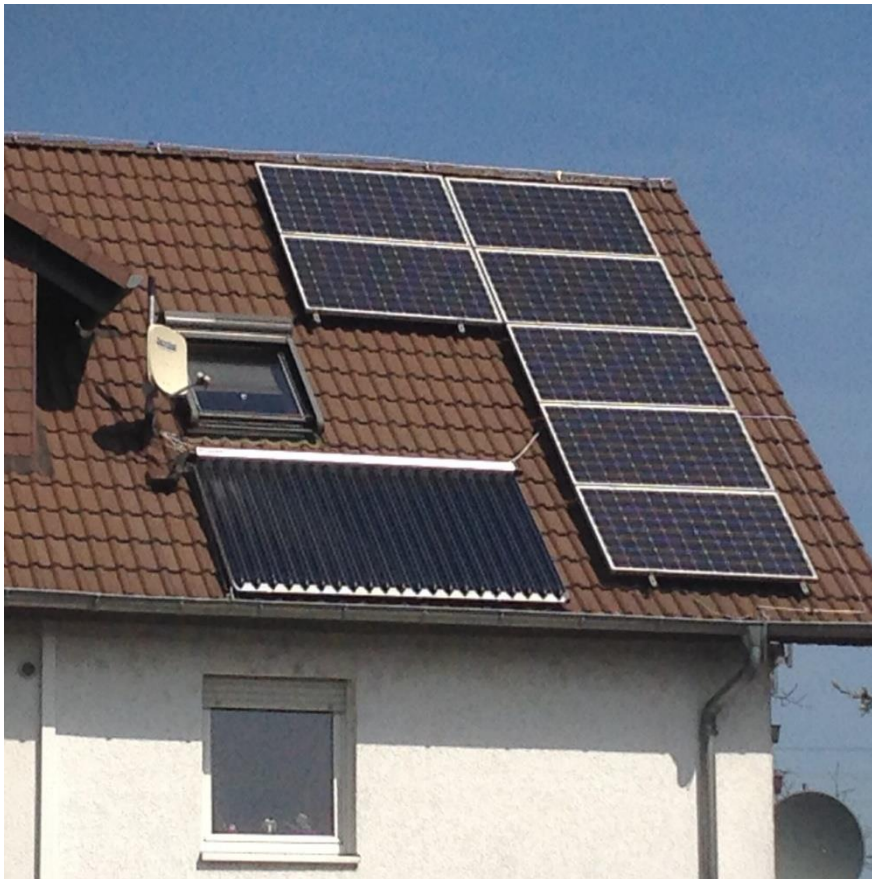
Photovoltaik mit Solarthermie-Röhrenkollektoren auf einem Reihenhaus.
