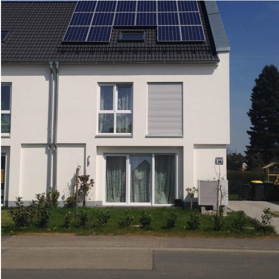
Kombination von Photovoltaik und Wärmepumpe. Das Ansaugteil für die Umgebungsluft ist hier viereckig.
